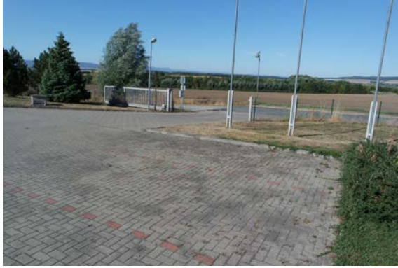
Bild 25 – Zufahrt zum Objekt
