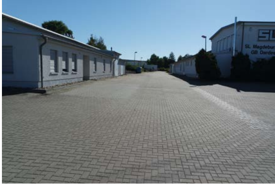
Bild 7 – Zufahrt Hauptgebäude, Hallenneubau, Garagen
