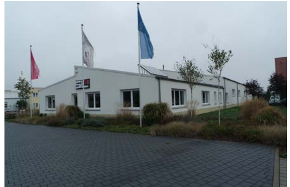
Bild 2 – Ansicht West u. Süden
