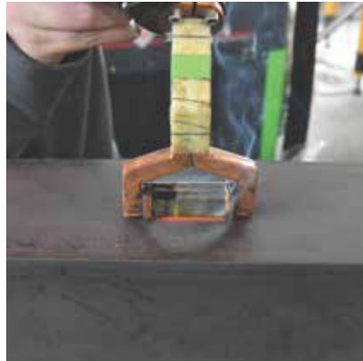
Bild 4: Induktor mit Feldverstärker beim Richten eines Längsträgers
